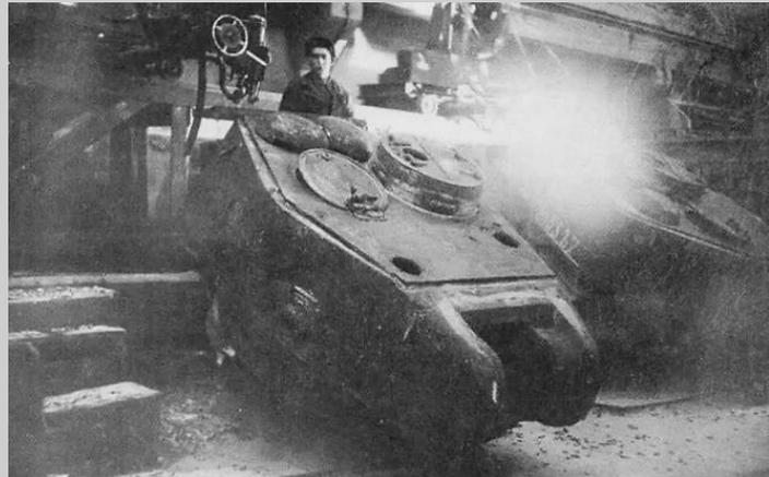
Fertigung von Panzertürmen für den Panzer T-34/85 im Werk Nr. 183 nach Wiederaufnahme der Produktion in Charkow im Jahre 1944
